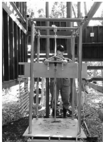
写真2: フレームを用いて井戸を掘削する様子
